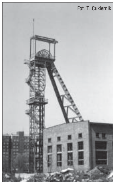
Szyb kopalni Siemianowice
